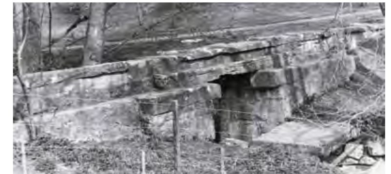
Aquädukt über den Eigibach bei der Brunnenwiese, 1976.
